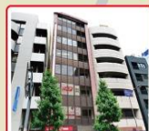
TKP飯田橋 ビジネスセンター 東京都新宿区下宮比町3-2 飯田橋スクエアビル3F
